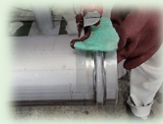
管端部電解研磨
