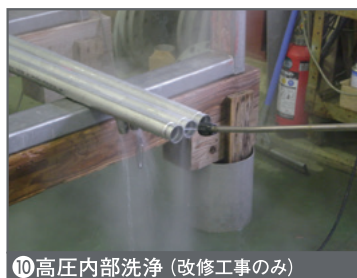
⑩高圧内部洗浄 (改修工事のみ)
