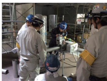
施工指導の様子 現場へ直接伺います
