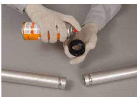
2 耐塩素ゴムリングの内外面に潤滑スプレーを散布する。
