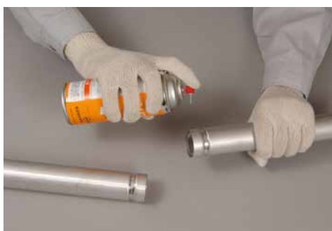
3 ステンレス管の端部外面に潤滑スプレーを散布する。
