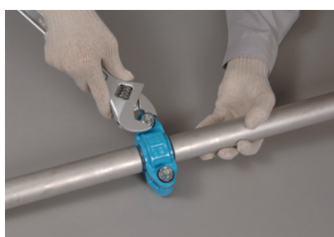
6 ボルト・ナットを左右均等に締めて下さい。
