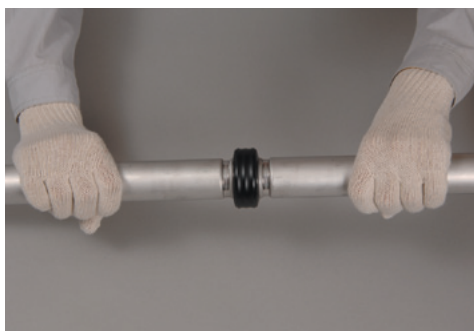
4 耐塩素ゴムリングを両方の管の端部に均等にはめる。
