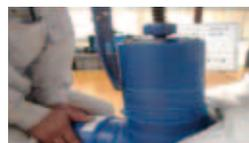
熱融着の阻害となるポリエチレン酸化皮膜・付着物を確実に除去させるため、高性能ポリエチレン管接合部全周の表皮を除去します。除去後、紙ウエスを用いて接合部をアセトンにて清掃します。
