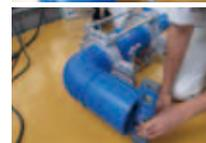
EF接合中に融着面がずれると、融着不良・接合面の剥離などが発生します。専用治具を使用し、PE管・管継手を固定します。
