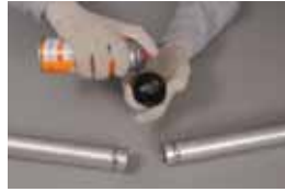
2 ゴムリングの外側に潤滑スプレーを散布する
