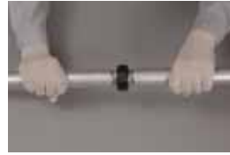
4 ゴムリングを両方の管の端部に均等にはめる
