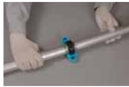
5 ハウジングをゴムリングの上にセットする
