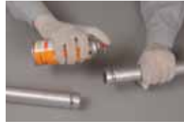
3 ステンレス管の端部に潤滑スプレーを散布する
