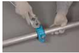
6 ボルト、ナットをはめて左右均等に締めます
