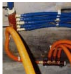
ポリプロピレン用ヘッダー施工例
